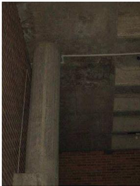
**Foto Nº 7.** Se evidencian columnas circulares, que tienen mayor valor por análisis de precios unitarios que las de sección cuadrada, porque se requiere diseñar la formaleta..
