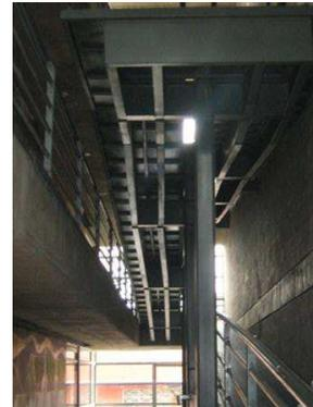
**Foto N° 3. En la zona central se encuentra cubierta que fue realizada posteriormente, por evidenciarse problemas con humedad y manejo de aguas lluvias.**
